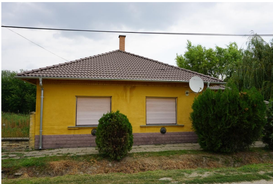
1960-as években épült lakóház új tetővel
